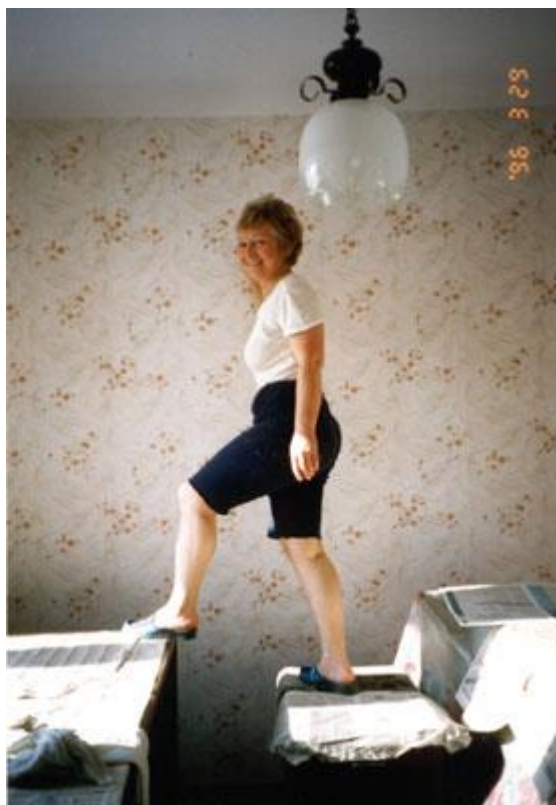
Ремонт в Митиной комнате. Март 1996 г.
