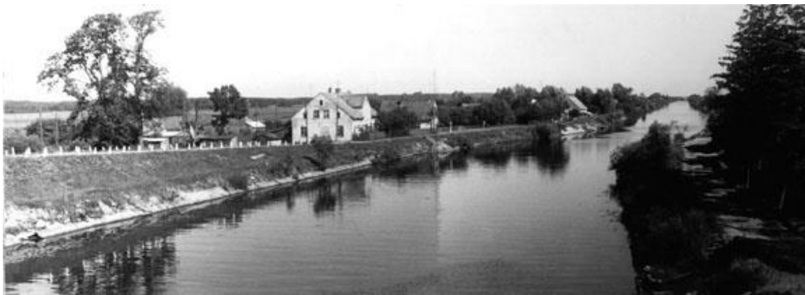
Полесский канал (вид с моста через него)
